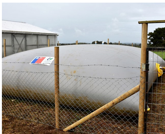
Fuente: VideoSur. Sistema de captación de aguas de lluvia, SCALL, para abastecer invernadero.
